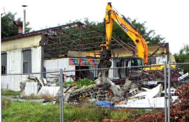
Les travaux de démolition de l'ancien garage Petit ont débuté
