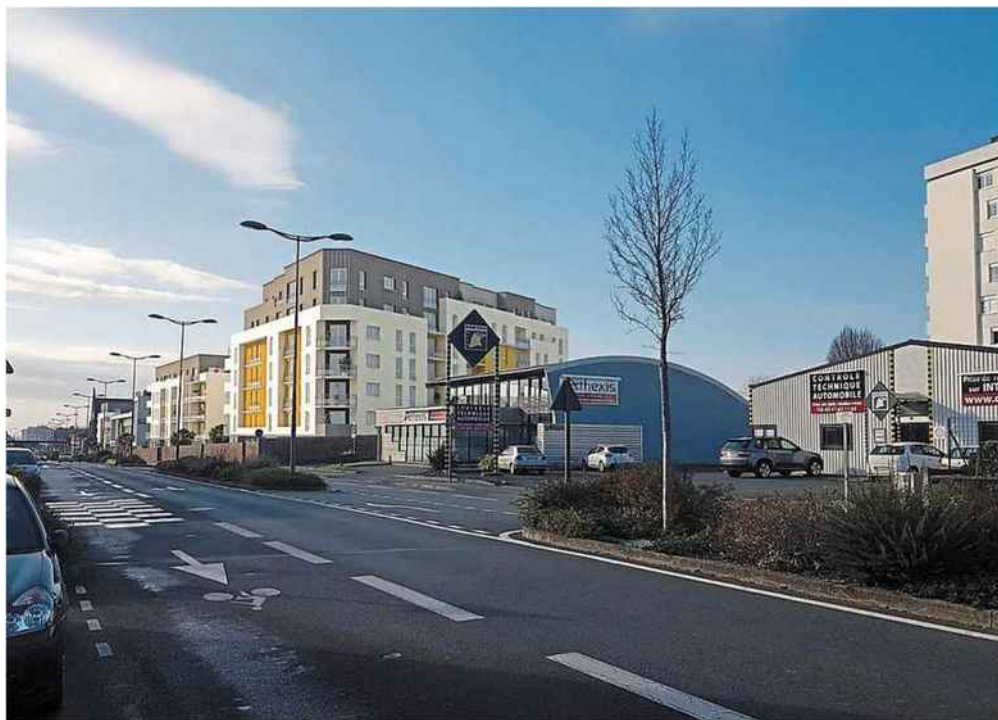
Trois bâtiments doivent être construits le long de l'avenue du Maréchal-Leclerc, entre la gare SNCF et Thalès.
