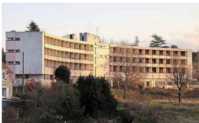
Construite en 1970, l'ancienne résidence Bellevue va être démolie dans les semaines à venir.
