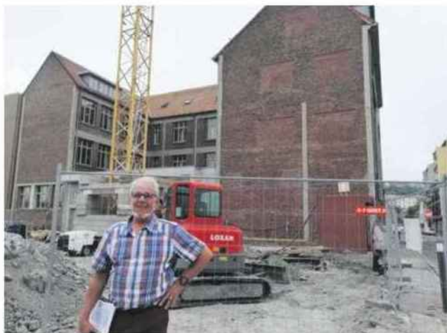
François Quibel est responsable de la mise en œuvre des opérations nouvelles pour Sodineuf Habitat normand. Rue Desmarquets, le chantier avait été interrompu en raison de la crise sanitaire. Il a repris il y a quelques semaines et les travaux liés aux fondations profondes sont terminés.
